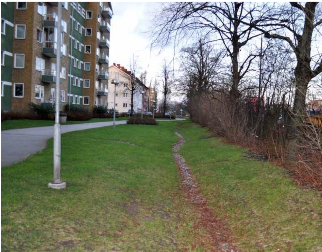
Figur 2. Svackdike. Bild från Svalövs kommuns dagvattenpolicy.
